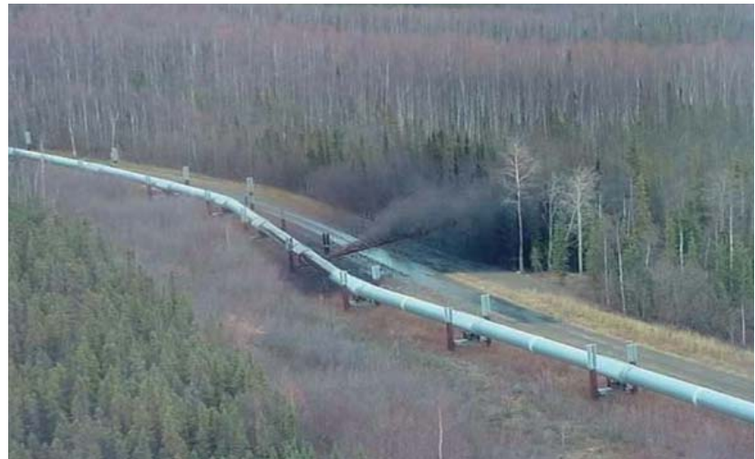
Aspetto della perdita di prodotto petrolifero lungo un oleodotto
