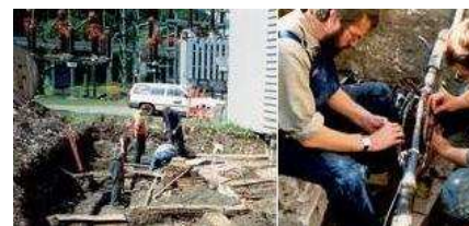
Operazioni di riparazione cavi
